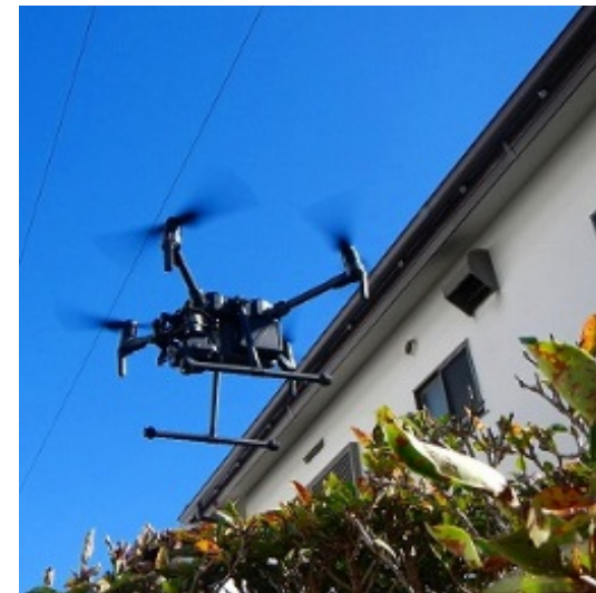
UAVsを活用した外壁点検業務
